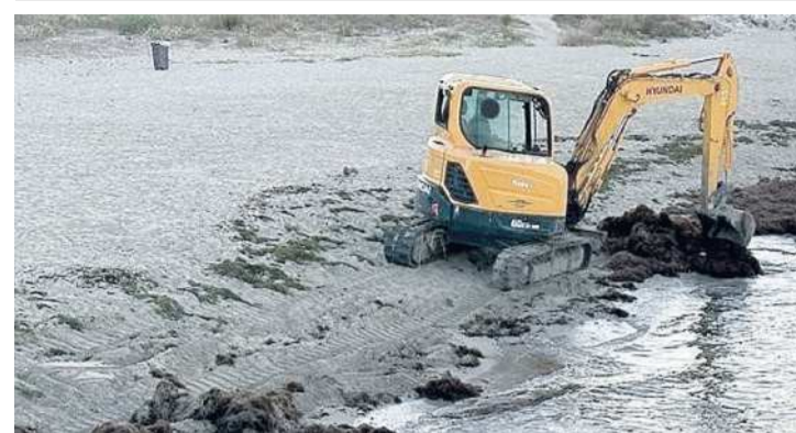
Le fasi dell'intervento a Lido Bruno
